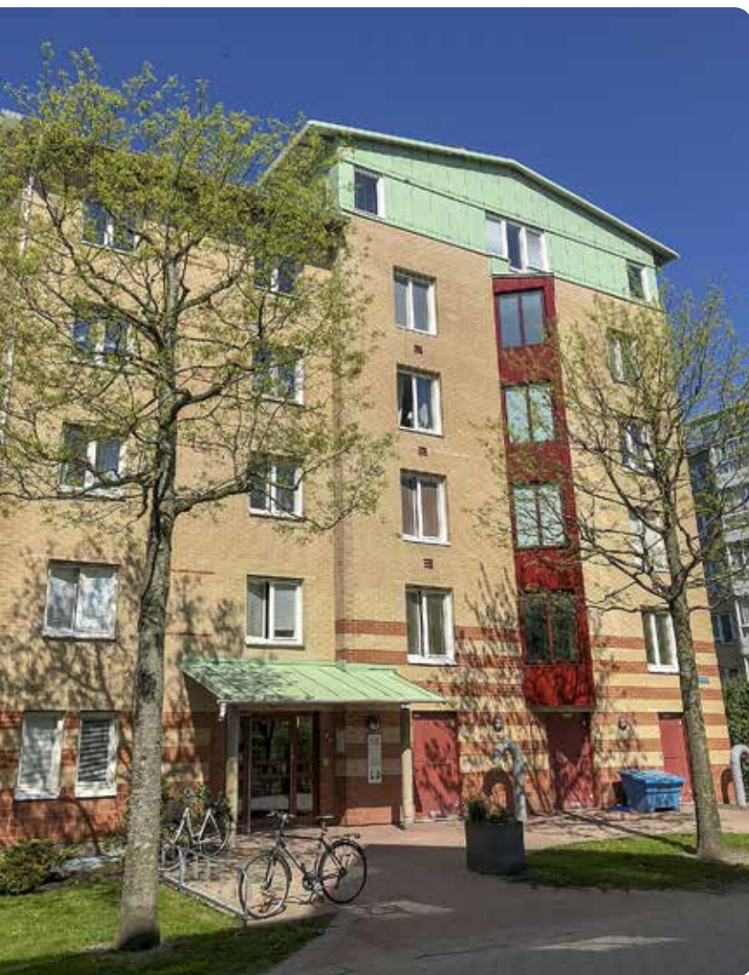
Skonaren, ett av de populära husen på Stenunge Strand med utsikt mot havet.
